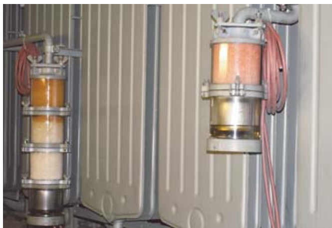
Vor dem Einbau ...
