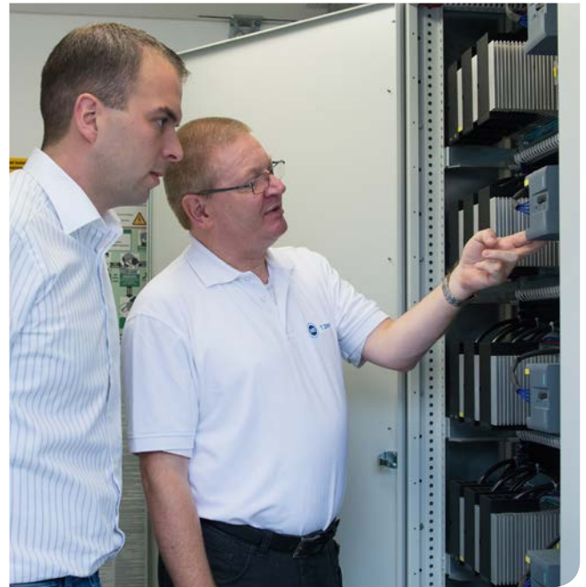
Hier erklärt unser Regionalvertriebsleiter Nord die Funktion der Wirkungsweise der Thyristoren für den dynamischen Anteil der Regelung.
