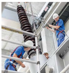
Наши эксперты при замене ввода на стороне ВН ( U_m = 300 \text{ кВ} ) на силовом трансформаторе 125 МВА
