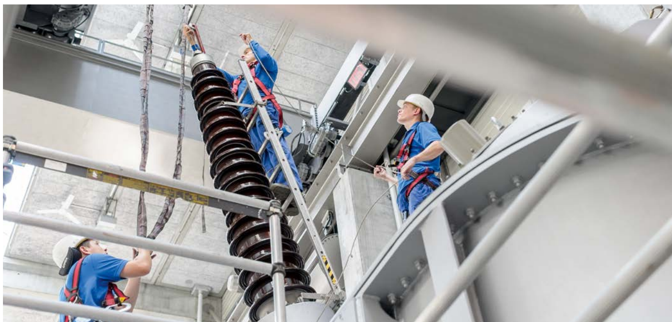
Наши эксперты при замене ввода на стороне ВН ( U_m = 300 \text{ кВ} ) на силовом трансформаторе 125 МВА
