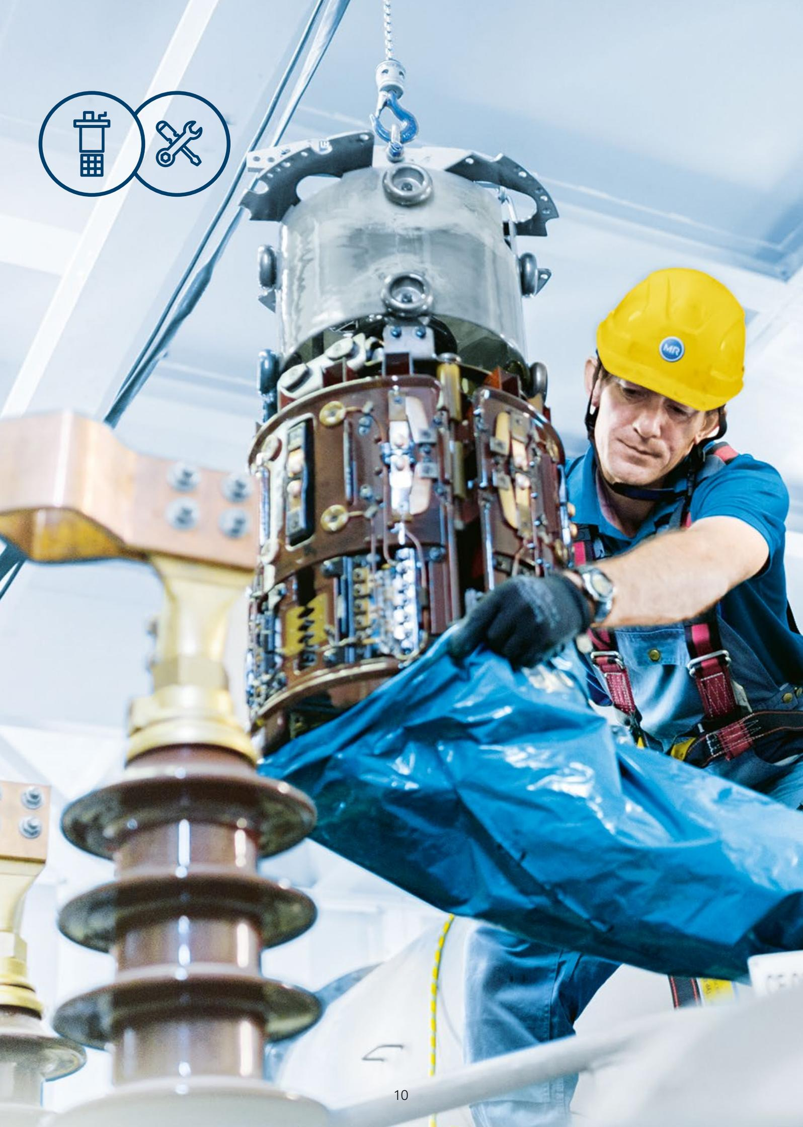
**||** *Der Laststufenschalter ist die wichtigste Komponente in einem geregelten Transformator. Die Wartung und Pflege dieses Präzisionsgeräts ist deshalb von höchster Bedeutung. Mit dem TESSA® Premium Service stellen wir sicher, dass der Laststufenschalter über die gesamte Lebensdauer des Transformators zuverlässig und auf aktuellem Stand der Technik funktioniert. Weltweit und auch für Fremdfabrikate.“*
