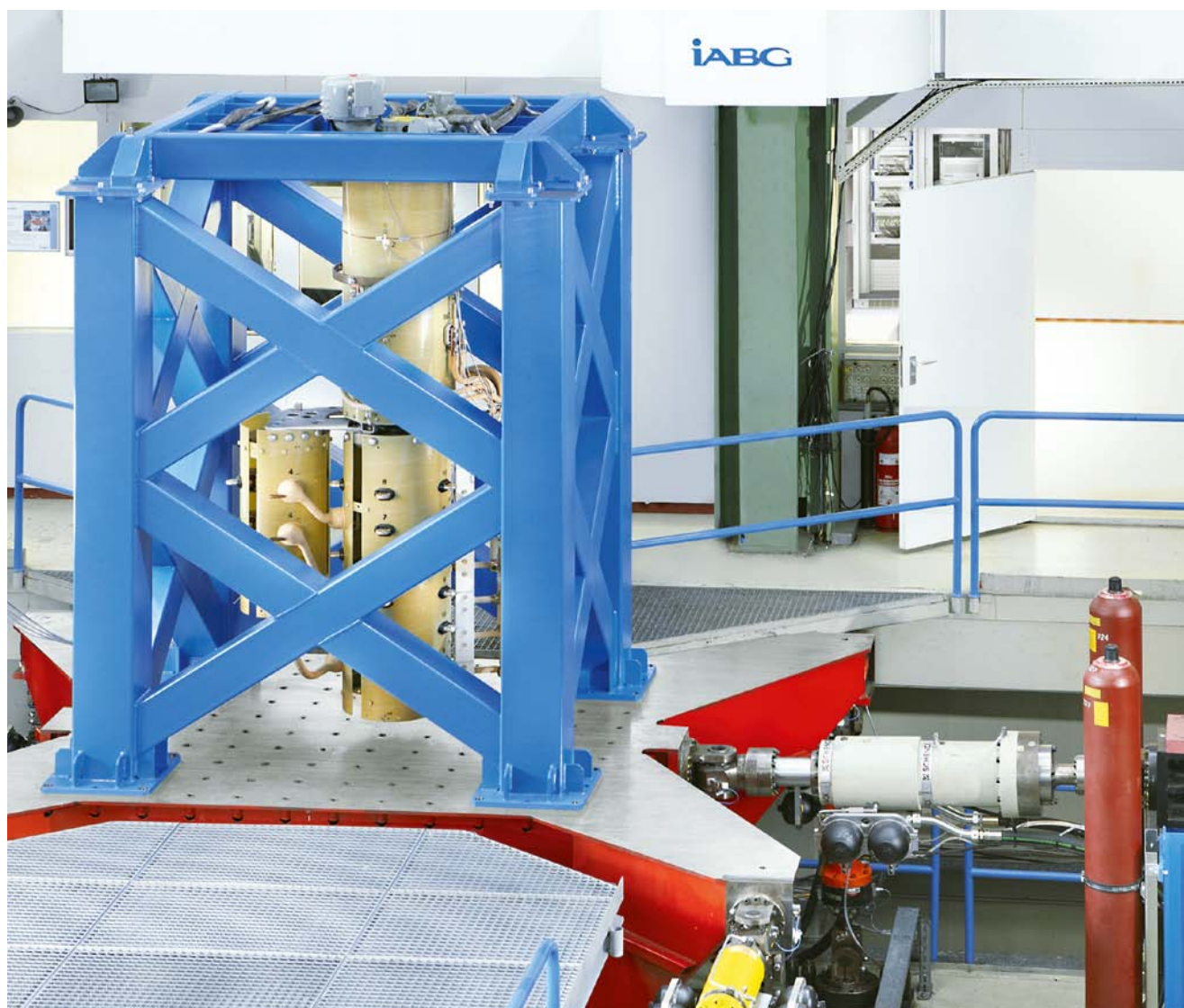
ミュンヘン市近郊のオットーブルン(Ottobrunn)にあるIABG社試験設備内のVACUTAP® VR®。
